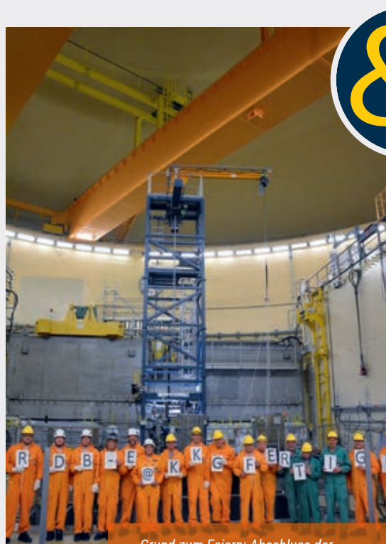
Grund zum Feiern: Abschluss der Zerlegearbeiten durch ZerKon im KKG.
