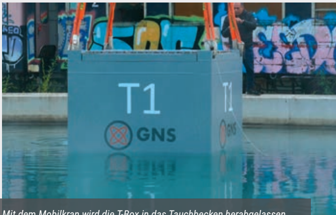
Mit dem Mobilkran wird die T-Box in das Tauchbecken herabgelassen.
