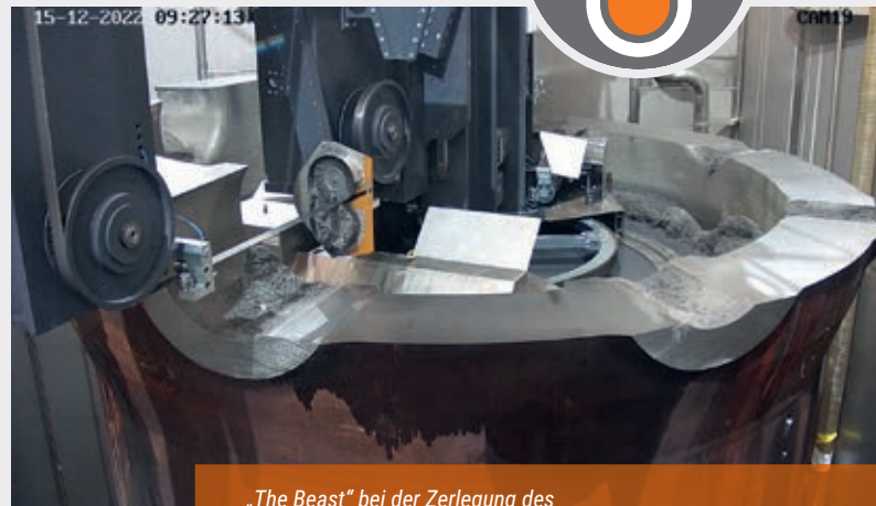
„The Beast“ bei der Zerlegung des RDB-Flanschbereichs im KKU.
