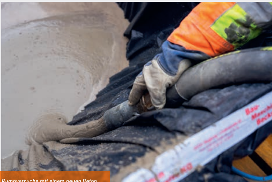
Pumpversuche mit einem neuen Beton.
