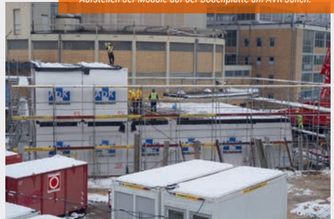
Aufstellen der Module auf der Bodenplatte am AVR Jülich.
