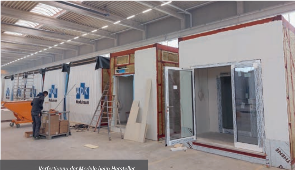
Vorfertigung der Module beim Hersteller.
