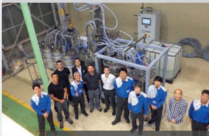
Inbetriebnahme der FAFNIR Test Plant am Standort Chita.
