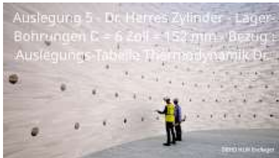
Lager-Bohrungen Innen-DBHD HLW Endlager_Auslegung 6 - Dr. Herres Zylinder - 337 m mit D 152 mm lng. Goebel_Arch_Gorunenkeno.jpg 1260K
