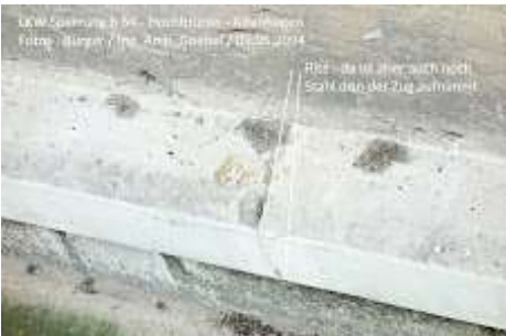
35__Hochbrücke_Altenhagen_B54_kleinere_Schäden_aus_Berg-Hang-Druck_Ing_Arch_Goebel_Hagen_09.05.2024.jpg 487K
