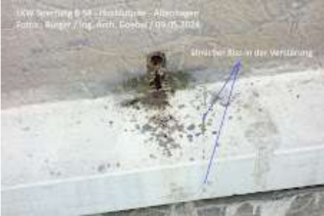
30__Hochbrücke_Altenhagen_B54_kleinere_Schäden_aus_Berg-Hang-Druck_Ing_Arch_Goebel_Hagen_09.05.2024.jpg 502K
