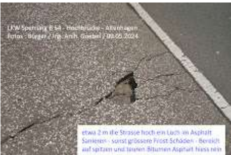
46___Hochbrücke_Altenhagen_B54_kleinere_Schäden_aus_Berg-Hang-Druck_Ing_Arch_Goebel_Hagen_09.05.2024 (1).jpg 761K
