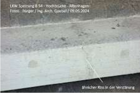
29__Hochbrücke_Altenhagen_B54_kleinere_Schäden_aus_Berg-Hang-Druck_Ing_Arch_Goebel_Hagen_09.05.2024.jpg 448K
