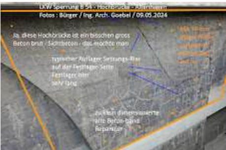
32__Hochbrücke_Altenhagen_B54_kleinere_Schäden_aus_Berg-Hang-Druck_Ing_Arch_Goebel_Hagen_09.05.2024.jpg 630K
