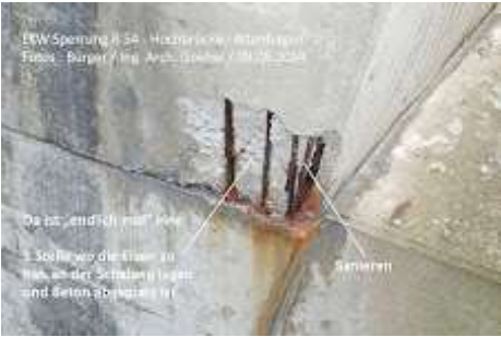
36___Hochbrücke_Altenhagen_B54_kleinere_Schäden_aus_Berg-Hang-Druck_Ing_Arch_Goebel_Hagen_09.05.2024.jpg 506K
