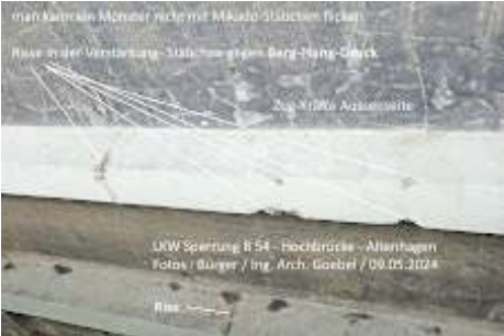
34__Hochbrücke_Altenhagen_B54_kleinere_Schäden_aus_Berg-Hang-Druck_Ing_Arch_Goebel_Hagen_09.05.2024.jpg 470K
