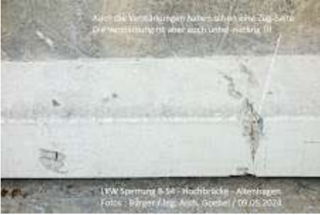
27__Hochbrücke_Altenhagen_B54_kleinere_Schäden_aus_Berg-Hang-Druck_Ing_Arch_Goebel_Hagen_09.05.2024.jpg 470K
