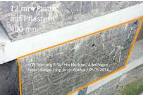
33__Hochbrücke_Altenhagen_B54_kleinere_Schäden_aus_Berg-Hang-Druck_Ing_Arch_Goebel_Hagen_09.05.2024.jpg 549K
