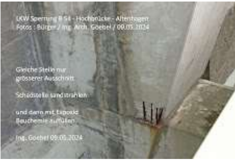
37___Hochbrücke_Altenhagen_B54_kleinere_Schäden_aus_Berg-Hang-Druck_Ing_Arch_Goebel_Hagen_09.05.2024.jpg 416K
