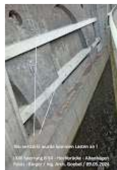
26_Hochbrücke Altenhagen_B54_kleinere_Schäden_aus_Berg-Hang-Druck_Ing_Arch_Goebel_Hagen_09.05.2024.jpg 214K
