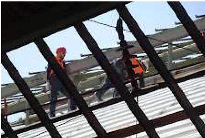
41_Baustelle-Sanierung-VST Hagen.JPG 2548K
