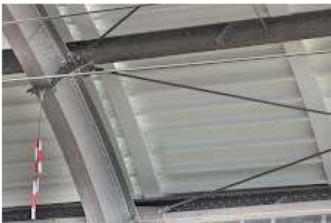
33_Baustelle-Sanierung-VST Hagen.JPG 3709K
