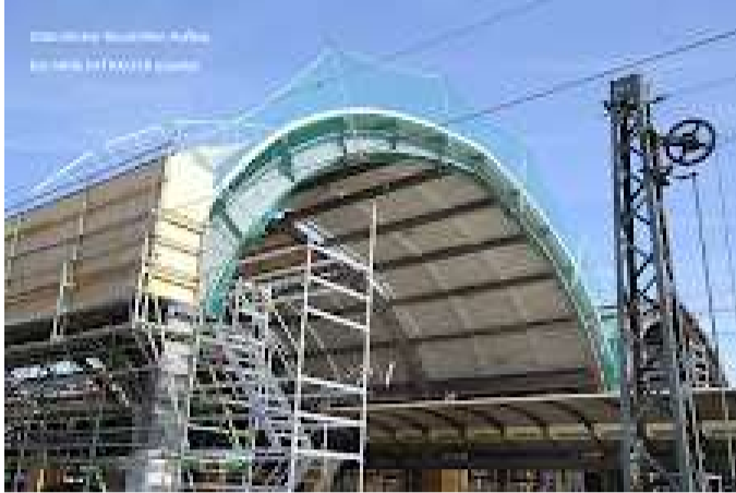
31_Baustelle-Sanierung-VST Hagen.JPG 3795K
