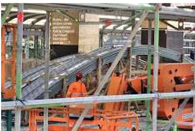
26_Baustelle-Sanierung-VST Hagen.JPG 4560K
