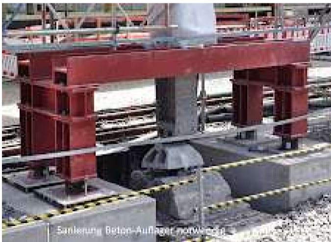
17_Baustelle-Sanierung-VST Hagen.JPG 1583K
